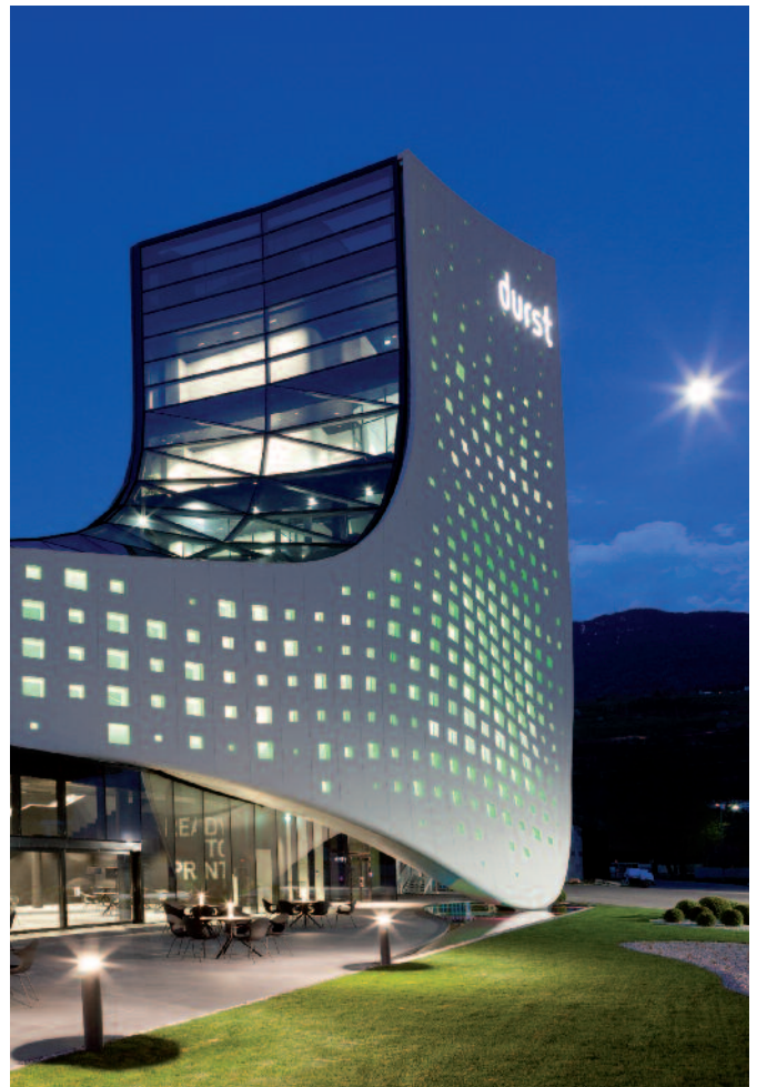
Das Durst Headquarter hat das Potenzial ein Wahrzeichen für den Industriestandort Brixen zu werden. Die Pixelfassade steht sinnbildlich für das Geschäft des Unternehmens. Denn Durst ist im digitalen Druck tätig.
