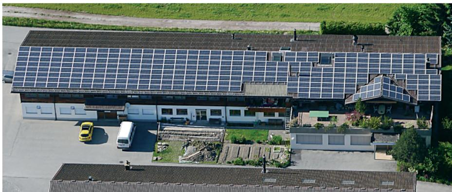
**280 Panels à 240 Watt produzieren ab Taghelle bis nach Sonnenuntergang jährlich rund 80.000 kWh Strom. Genau dann am meisten (Mittagszeit), wenn am meisten verbraucht wird. Auch bei Wolken und Nebel wird Strom produziert, nur etwas weniger.**
