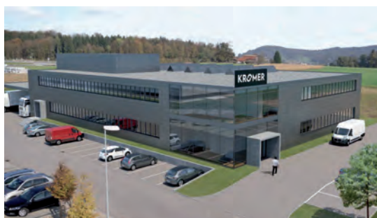
Mitte 2017 will die Kromer-Gruppe diesen Neubau beziehen.
