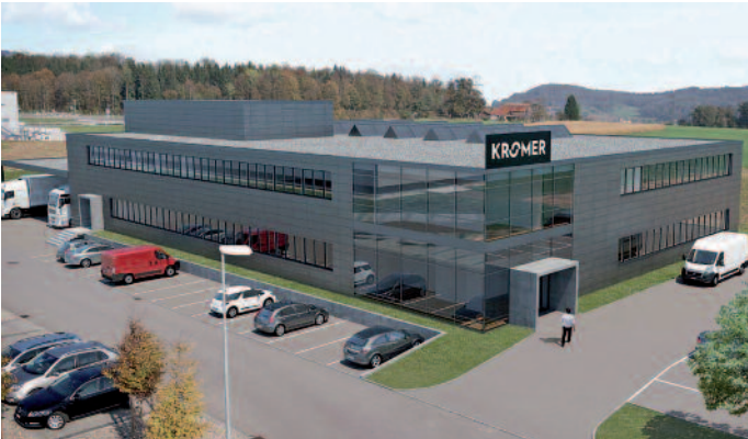
Ein Neubau «auf der grünen Wiese» erlaubt die Umsetzung neuer Ideen und Lösungen, die speziell für die Bedürfnisse der Kromer Gruppe geschaffen werden.
