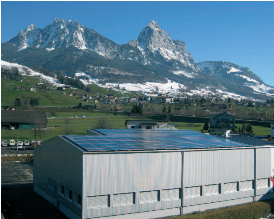
Photovoltaikanlage auf dem Dach der Zeitungsdruckerei.
