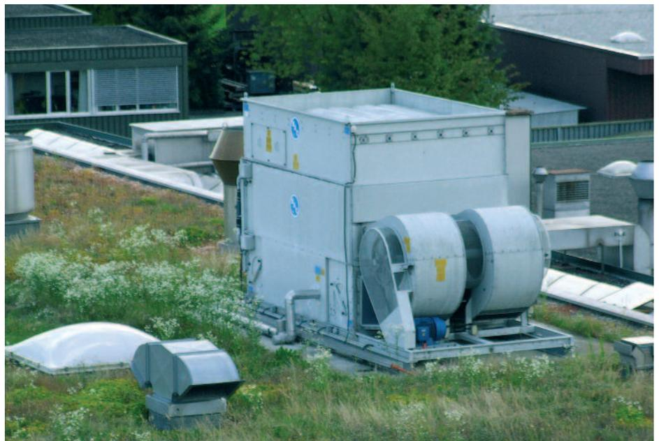
Wärmetauscher auf dem Dach der Rotationshalle für die Wärmerückgewinnung
