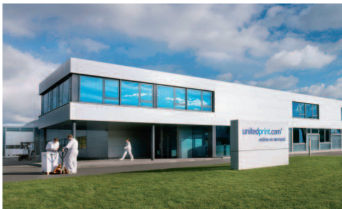
Die Zentrale von Unitedprint in Radebeul.
