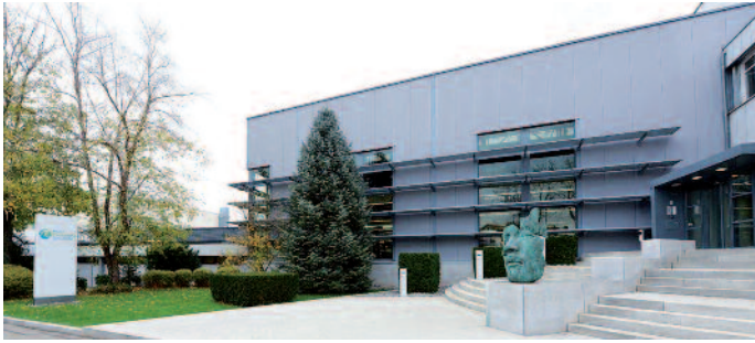
Der Eingangsbereich von MPS in Obersulm. Hier erlebten mehr als 70 Kunden Anfang November die Weltpremiere der Heidelberg Primefire 106 und konnten sich dabei über die Möglichkeiten der Digitaldrucktechnik in der Praxis der Faltschachtelherstellung überzeugen.
