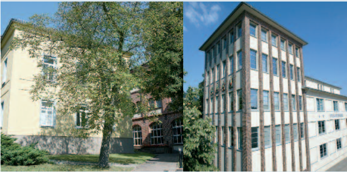
Das Verwaltungsgebäude und ein Teil der Produktion. Daneben rechts der Lagerturm mit historischen Spielkartenfiguren – Wahrzeichen der Spielkartenfabrik
