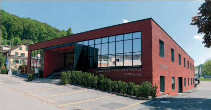
Das Gebäude der J.E. Wolfensberger AG in Birmensdorf: erster und bislang einziger nach dem Minergie-Standard konzipierter Druckereibau in der Schweiz.
