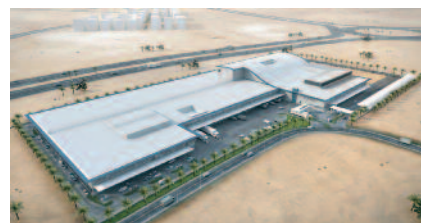
Das hochmoderne, neue Druckzentrum von Al Nisr Publishing mitten in der Wüste Dubais.
