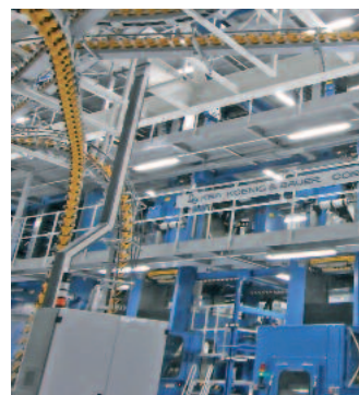
Die drei Falzwerke mit angeschlossenen Exemplarfördersystemen von Ferag sind in der Mitte der Cortina-Rotationslinie angeordnet.
