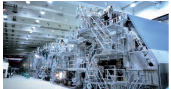
Umbau: PM10 produziert zukünftig Wellpappenrohpapier auf Basis von Recyclingpapier.
