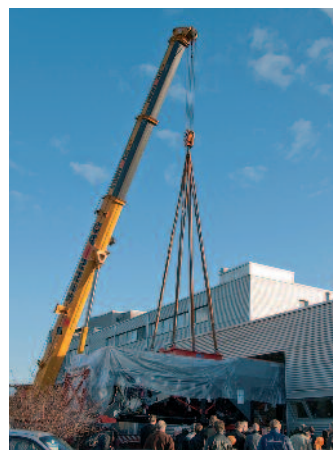
Mit der Anlieferung des über 9 m langen Auslegers der Speedmaster XL 145-5+L wurde bei der Schläefli & Maurer AG die Montagephase am 8. Dezember 2009 eingeleitet.
