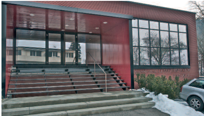
Das moderne Druckzentrum in Birmensdorf wurde 2005 vollständig nach Minergie-Richtlinien konzipiert und gebaut.
