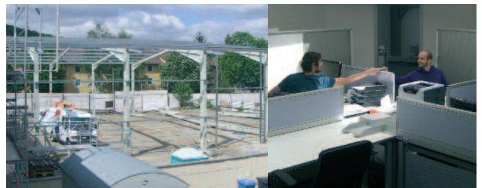
Das Sprintis-Grundstück bei Baubeginn. Neugeschaffene Räume im 1.Stock.
