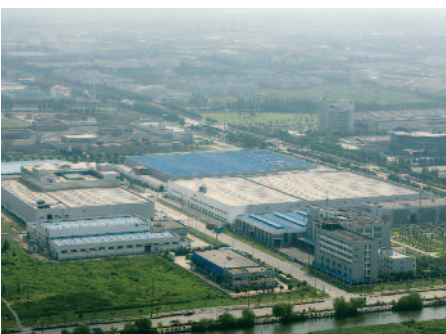
Der erweiterte Heidelberg Standort Qingpu bei Shanghai mit neuer Montagehalle und Logistikzentrum verfügt jetzt über eine Produktionsfläche von rund 45.000 m 2 .
