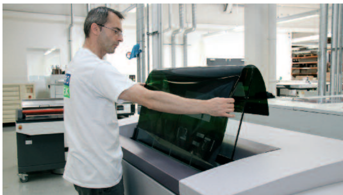
Das Bebilderungssystem wurde Anfang Juni 2011 bei Repro Busek installiert und bereits nach drei Tagen liefen die ersten Aufträge auf der Anlage.
