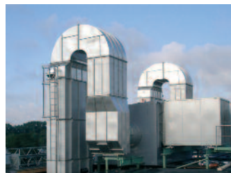
Wärmerückgewinnung von Papiermaschinen.
