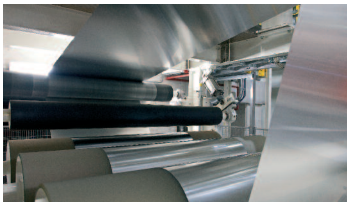
Die neue Plattenstraße ist 330 Meter lang, durchschnittlich 35 Meter breit und bis zu 22 Meter hoch. Bis zur Fertigstellung wurden 850 Tonnen Stahl und 5.500 m 3 Beton verbaut.
