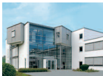
Verwaltungsgebäude in Ulm.
