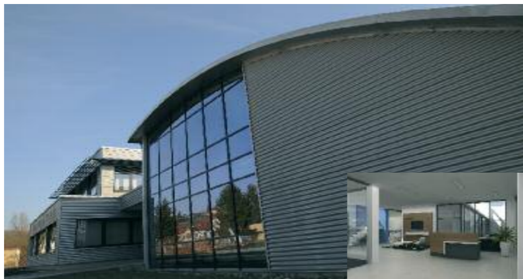
Wer hier an Wellblechbaracke denken mag, liegt völlig daneben. MBO hat das neue Gebäude in Übereinstimmung zwischen der MBO Unternehmensidentität und räumlicher Arbeitswelt auf beeindruckende Weise erlebbar gemacht. Die dafür geschaffene zusätzliche Nutzfläche von insgesamt 1.700 m 2 ist architektonisch geprägt von Offenheit, Klarheit und Geradlinigkeit.
