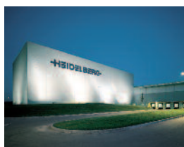
Vor rund 15 Jahren eröffnete Heidelberg das World Logistics Center in Wiesloch-Walldorf.
