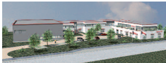
Eröffnung im September: das neue Trainings- und Konferenzzentrum von Horizon.
