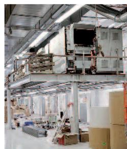
Auf 800 m<sup>2</sup> Produktionsfläche wird die neue Anlage gebaut. Dazu werden bis zu 7 Tonnen schwere Anlageteile in der Produktionshalle positioniert.
