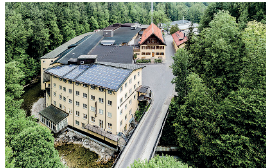
Die Papierfabrik Gmund deckt die Hälfte ihres Energiebedarfs mit Strom, der im eigenen Wasserkraftwerk erzeugt wird.
