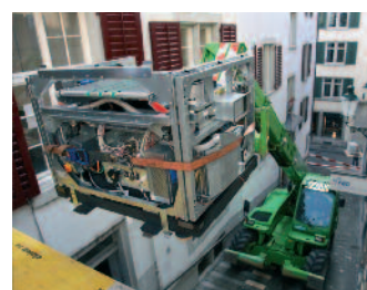
Das Einbringen der Technik (im Bild der Suprasetter) an der Trittligasse 2 erforderte spezielle Methoden.
