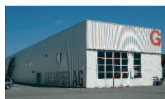
Die grosszügige Produktionshalle der Gremper AG in Pratteln bei Basel.
