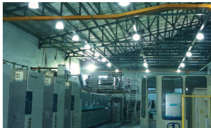
Die Maschine läuft wieder. Wer sich ein (bewegtes) Bild von der Installation machen will – hier der Link zu einem Video: http://snipurl.com/26scrc5 .
