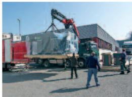
die Anlage in acht grossen Teilen, von denen jedes zwischen 6 und 11 Tonnen wiegt, mit fünf Sattelschleppern angeliefert. Die neue Druckmaschine, bestehend aus über 90 Tonnen Material, wird innert drei Wochen durch ein 4-köpfiges Spezialistenteam zusammgebaut. Der erweiterte Maschinenpark wird neu 30 Druckwerke umfassen, 25 davon im Format 70 x 100.
