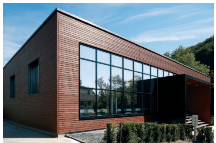
MINERGIE®-Standard im Industriebau – ein Schritt in eine neue Energiezukunft (Foto Renggli AG Sursee)
