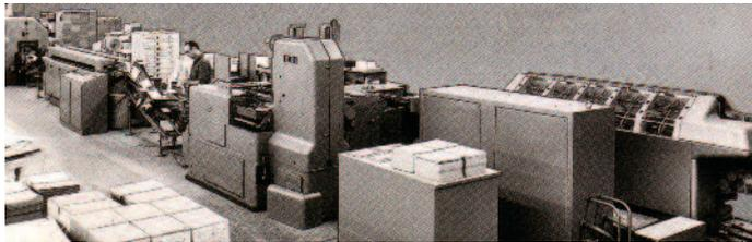
Unter der Ägide von August Kolbus hatte sich das Rahdener Unternehmen von einer Dorfschmiede zum Hersteller von Buchbindereimaschinen gewandelt. Den wirklichen Durchbruch für die automatisierte Buchherstellung schaffte Kolbus 1962 mit der ersten vollautomatisierten Buchfertigungsstraße, die 36 Bücher pro Minute produzierte.
