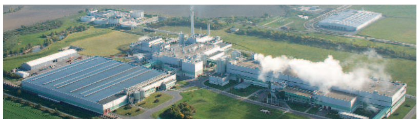
Der Schweizer Verpackungshersteller Model kauft für 32 Mio. € die Sachsenmühle in Eilenburg. Die bisher zum Sappi-Konzern gehörige Papierfabrik stellt jährlich 310.000 Tonnen Zeitungsdruckpapier her.
