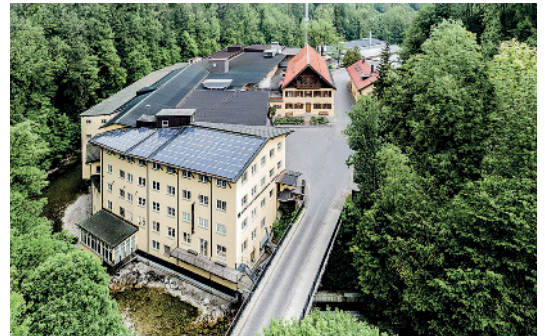
Die Papierfabrik Gmund deckt die Hälfte ihres Energiebedarfs mit Strom, der im eigenen Wasserkraftwerk erzeugt wird.
