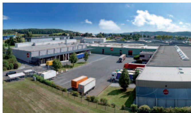
Überblick über das moderne Wellpappenwerk von Rondo in St. Ruprecht.
