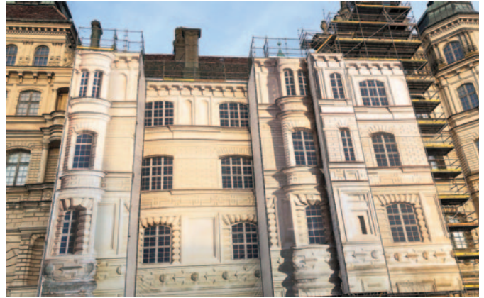
Während der Renovierung von Schloss Güstrow verdeckten großformatige Planen die Bauarbeiten. Die Besucher sahen zwar nur die bedruckten Banner, erhielten aber gerade deshalb eine gute Vorstellung davon, wie es später aussehen wird. (Bildquelle: HP.)
