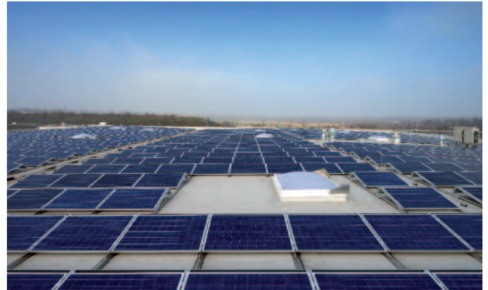
Auf einer Fläche von rund 1.500 m 2 erzeugen bei oeding 900 Solarmodule Strom, der direkt im Gebäude genutzt wird.
