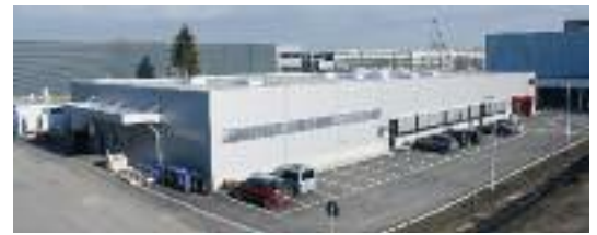
Mit der neuen Betriebsstätte in Berlin hat Baumer hhs die Produktions- und Lagerfläche verdoppelt und für die Kunden ein solution-center für das Testen neuer Anwendungen eingerichtet.
