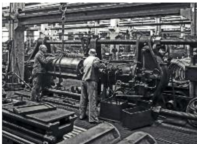
Mit großer Sorgfalt erfolgte im frühen 20. Jahrhundert das Einpressen der Zylinderachsen auf schweren hydraulischen Pressen.
