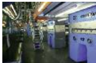
Vorhandene Druckeinheiten in hervorragendem Zustand.
