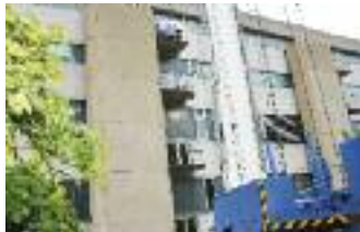
Der neue Klebbinder Alegro wurde mit einem Kran in den 3. Stock zur Buchbinderei Scherrer gehievt.
