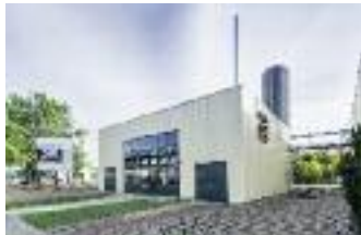
Das neue Blockheizkraftwerk am Standort Wiesloch-Walldorf der Heidelberger Druckmaschinen AG.
