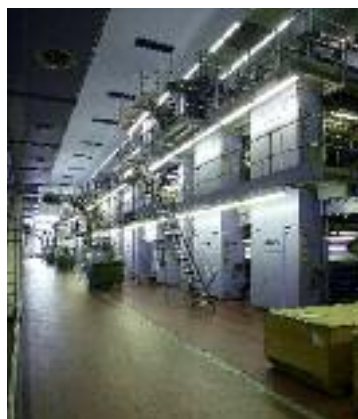
Die Überholung durch das PHS-Team hat die Produktionssicherheit der Geoman-Anlage in Dresden für die nächsten Jahre deutlich erhöht.
