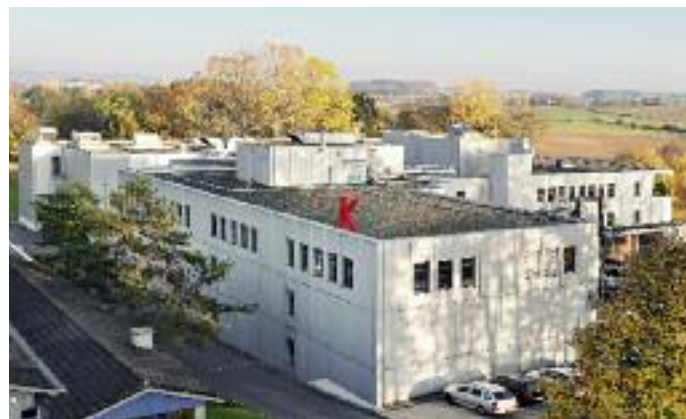
Das Betriebsgebäude der Druckerei Kyburz AG in Dielsdorf, etwa 15 km nordwestlich von Zürich.
