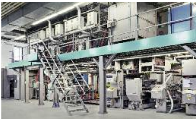
Teilsicht einer Jet Web-Finishing-Linie der Druckerei Kyburz AG mit zwei Inkjet-Towern auf der Galerie der Anlage.
