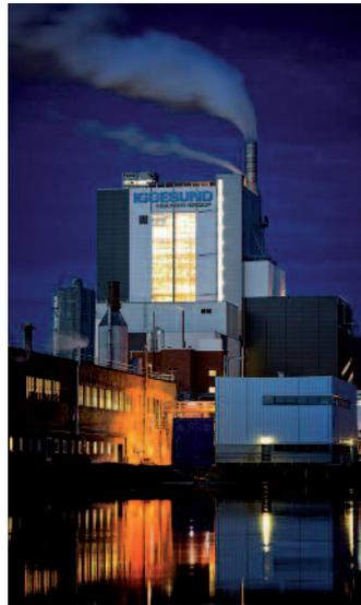
»In unserem Sulfatverfahren für die Zellstoffproduktion werden die Zellulosefasern separiert, die die Hälfte der Masse eines Baumstamms ausmachen«, erläutert Winblad von Walter. »Die andere Hälfte ist das Bindemittel des Holzes, das vor allem aus der energiereichen Substanz Lignin besteht. Diese verbrennen wir im Laugenkessel, wobei Dampf und Strom erzeugt wird, um mehr als 90 Prozent unseres Energiebedarfs zu decken.«
